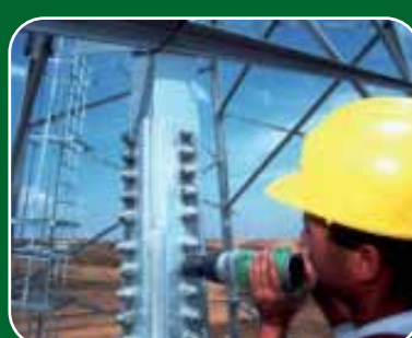
7. Montaggio tralicci
